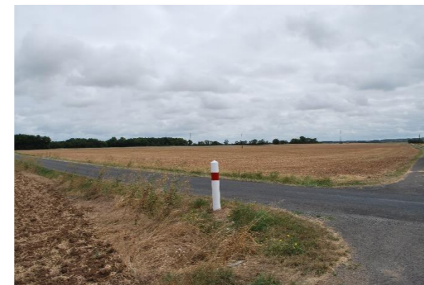
Route départementale RD88
