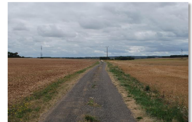
Voie communale (lieu-dit « Le Petit Fief »)
